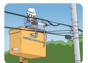
光ファイバー敷設
